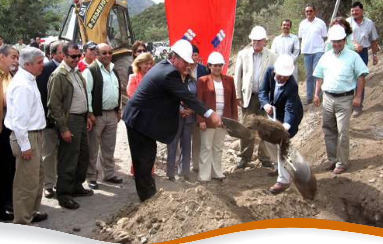
▼ La pavimentación del tramo chileno del Paso Pehuenche continúa a paso firme.
